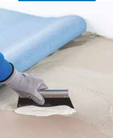
Påføring af Ultrabond Eco TX1
