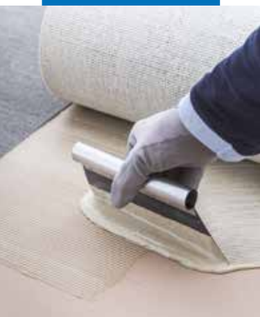
Montering af væg-til- væg-tæppe med Action Bac®-bagside
