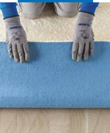
Montering af væg- til-væg-tæppe med filtbagside
